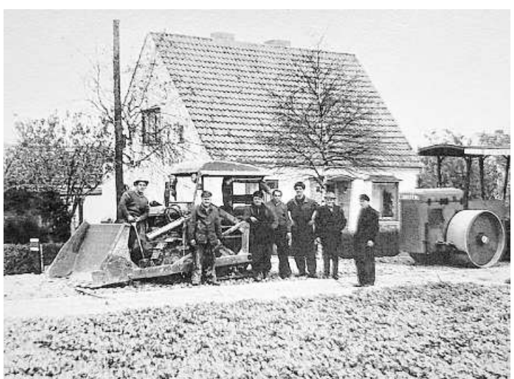
Ende der 50er-Jahre wurde das Viertel legalisiert, an das Kanalnetz angeschlossen und wurden Straßen gebaut. FOTO: JÜRGEN RIPPERT
